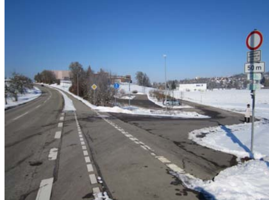
Heutige Einfahrt zur Eschenau von Süden; der geplante Kreisell liegt oberhalb der heutigen Einfahrt, 100m stadteinwärts
