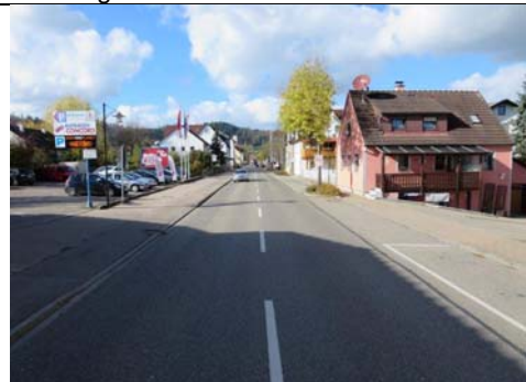
Gefährliche Überquerung des Radwegs an der Bahnhofstraße
