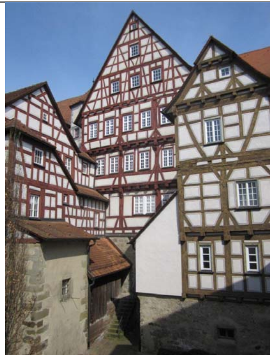
Bild 2: Privat, Südost-Ecke, Außenansicht
