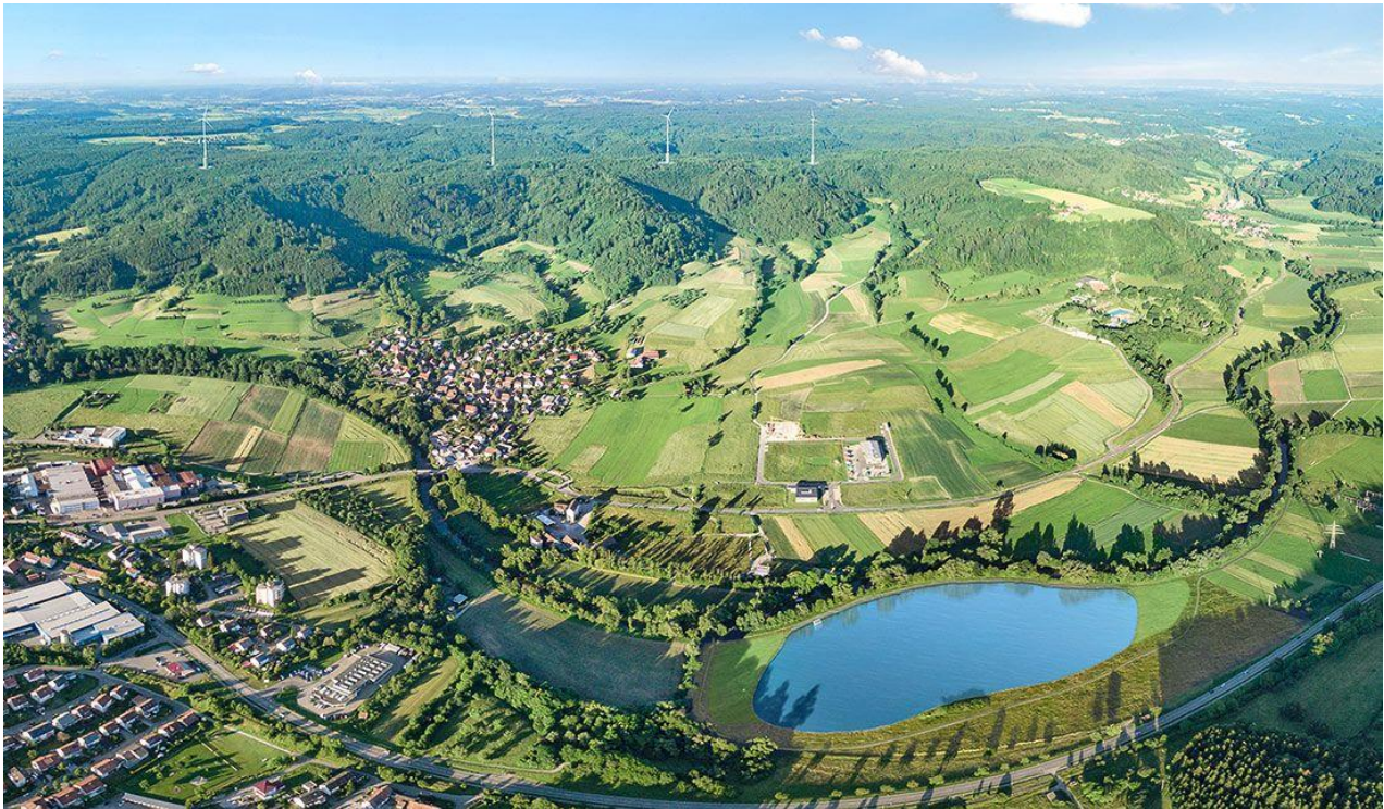
Abbildung 7: Luftbild des Gaildorfer Naturstromspeichers 20
